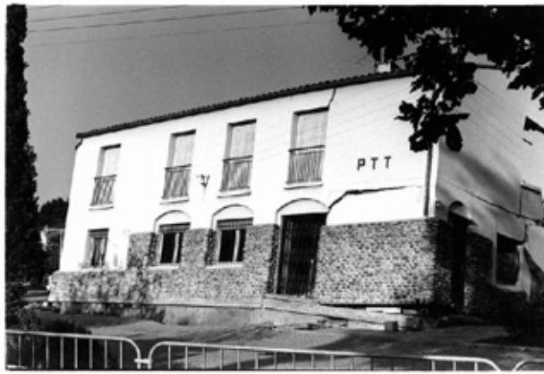
Bâtiment de la poste détruit à Malataverne
