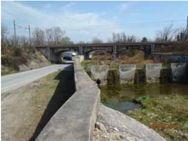
La Riaille sous le pont routier puis sous le pont SNCF
