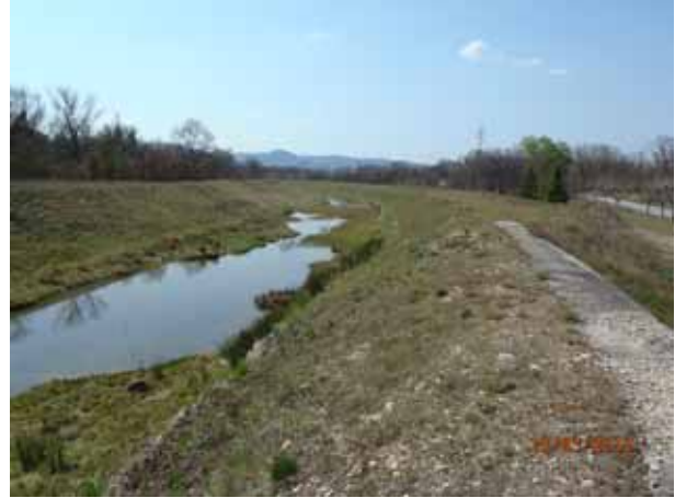
La Riaille endiguée jusqu'à son exutoire
