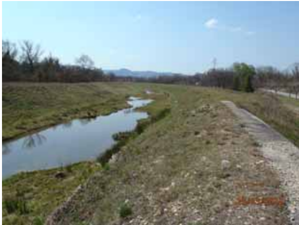
La Riaille endiguée à l'aval du pont SNCF
