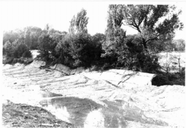
Digue détruite quartier de la Pagnère
