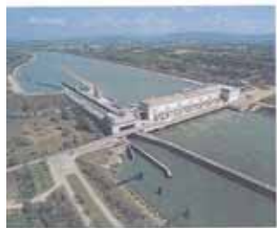
Il comprend deux ouvrages : le barrage de Rochemaure et la centrale-écluse de Châteauneuf-du-Rhône et assure 10 % de la production hydroélectrique de la CNR, soit près de 1,6 milliard de kWh par an.
