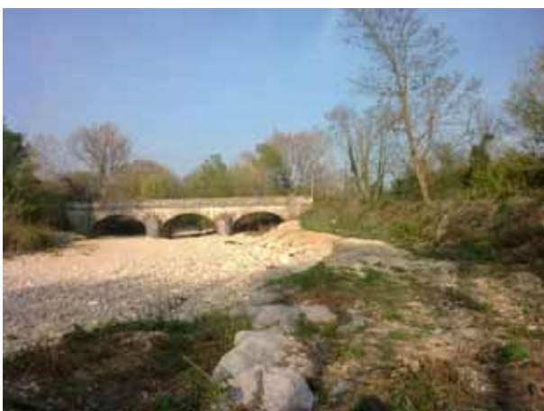
Ouvrage sous la RD484 submergé en 1988
