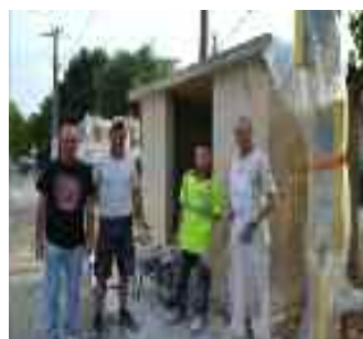
Crépi d'un abris bus.
