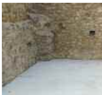
Rejointement d'un mur et mise en œuvre d'une dalle rue du Portail.
