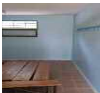
Peinture aux vestiaires du rugby dans le cadre des chantiers jeun's.
